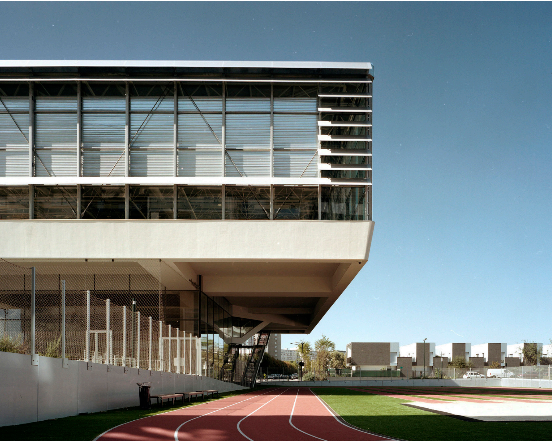
Asnières-sur-Seine, Arena Teddy Riner - - Du Besset-Lyon - Architectes
