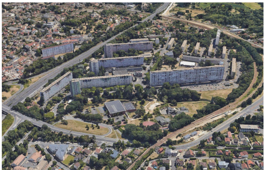
Vue aérienne du quartier Grand Vaux Grand Val
