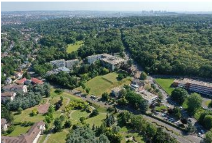
Vue aérienne du quartier - Crédit : © CITALLIOS
