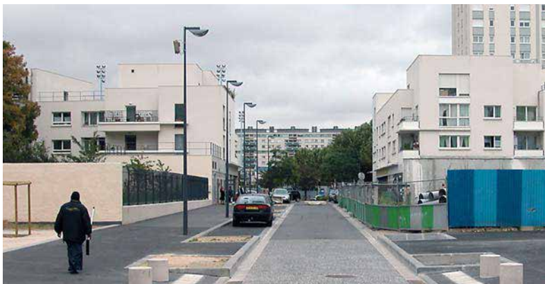
Vue arrière depuis la rue du Maréchal de Lattre de Tassigny
