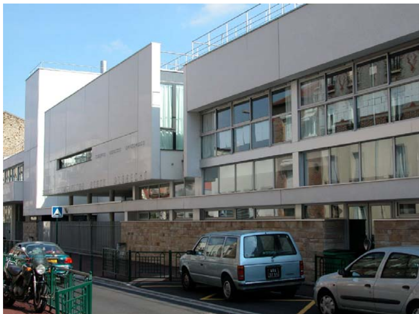
Façade rue Carnot
