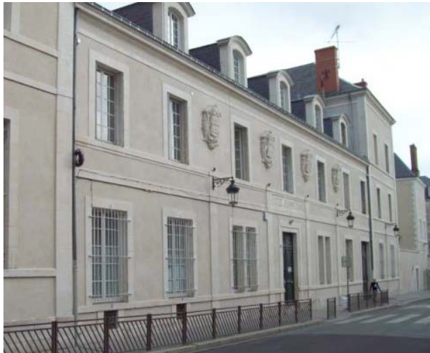
Façade rue : ancien accès
