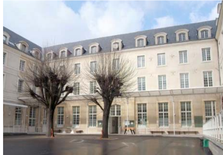
1ère cours intérieur
